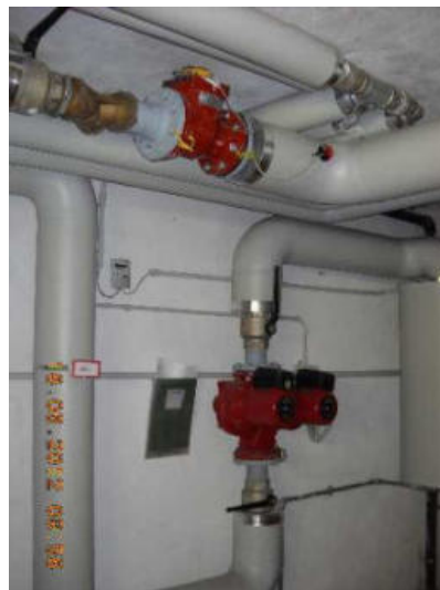
Collettore circuiti termici
