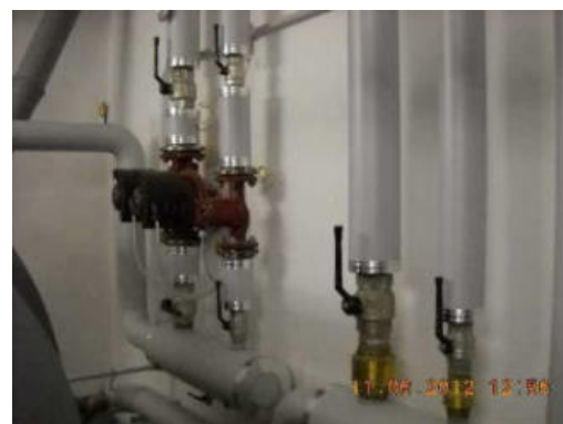
Collettore circuiti termici
