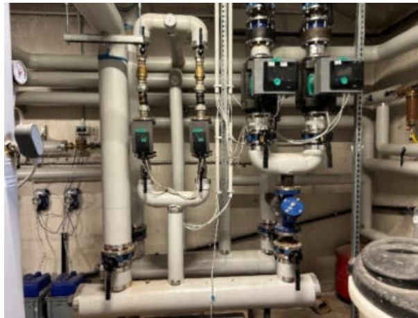
Collettore circuiti termici
