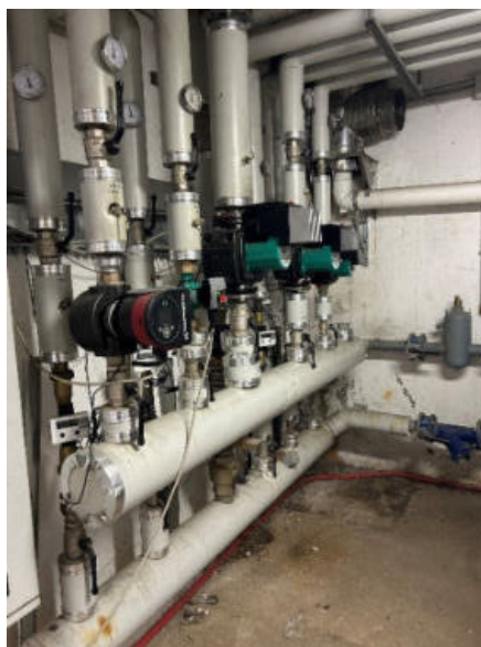
Collettore circuiti termici
