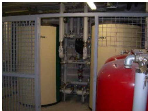
Accumulo solare e sanitario e circuiti solare
