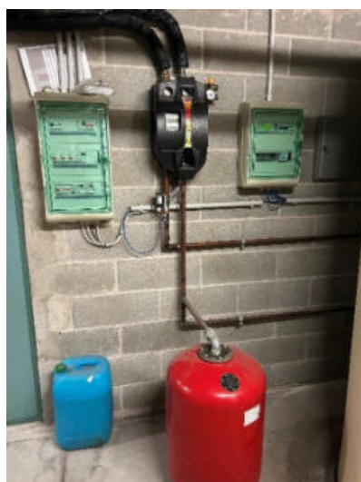
Quadro elettrico e gestione e pompa impianto solare
