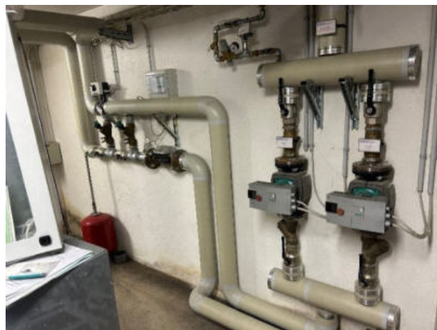
Collettore circuiti termici riscaldamento
