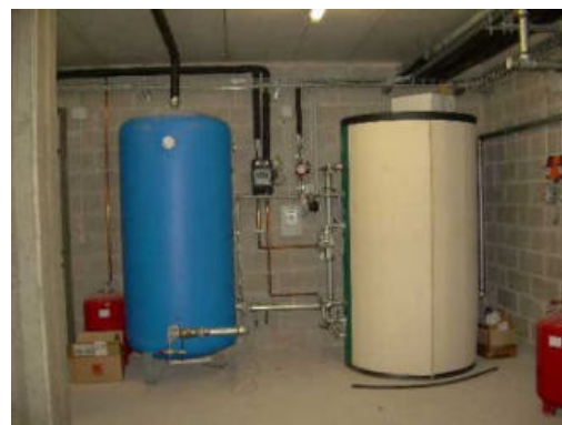
Accumulo solare e sanitario e circuiti solare
