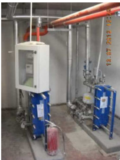
Generatori termici riscaldamento e sanitario da teleriscaldamento
