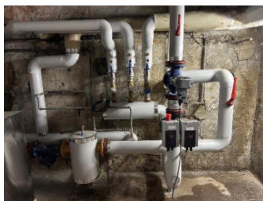
Collettore circuiti termici
