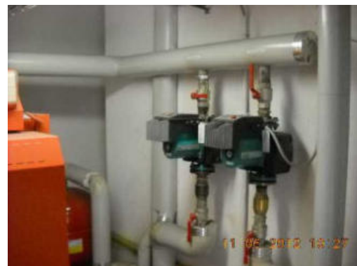
Collettore circuiti termici
