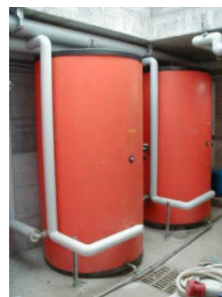
accumuli sanitario solare
