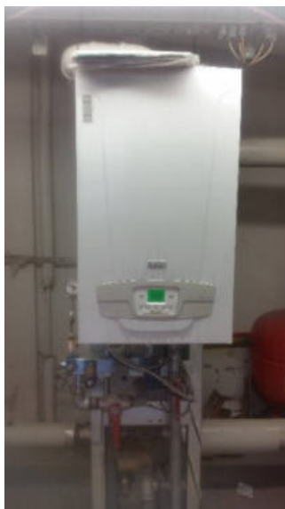
Generatore termico e scambiatore primario
