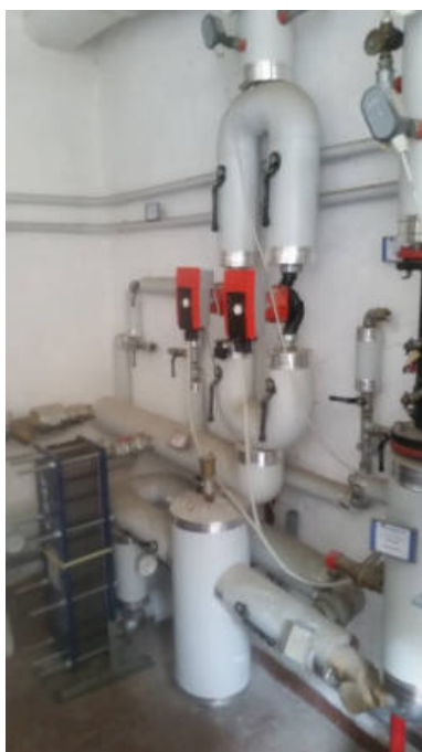
Collettore circuiti termici
