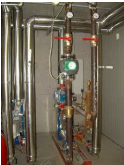
Generatori termici riscaldamento e sanitario da teleriscaldamento
