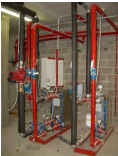
Generatori termici riscaldamento e sanitario da teleriscaldamento
