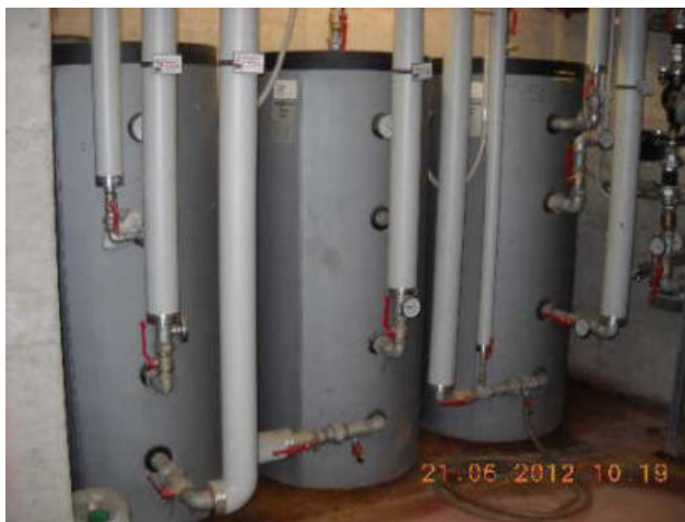
Accumulo sanitario e scambio solare
