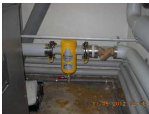
Filtro circuito riscaldamento
