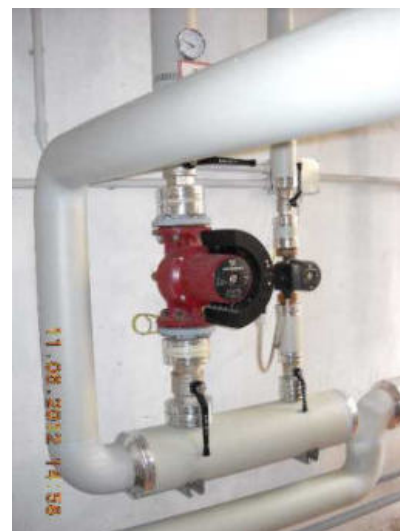
Collettore circuiti termici
