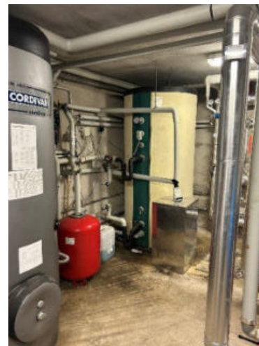
Accumulo solare e sanitario
