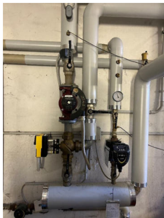
Collettore circuiti termici
