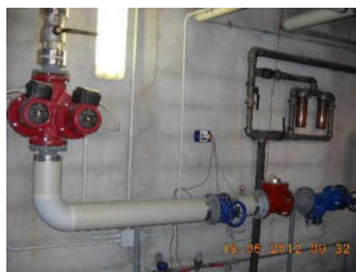
Collettore circuiti termici
