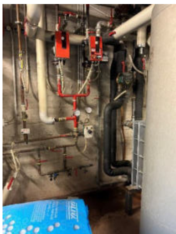
Collettore circuiti termici solare
