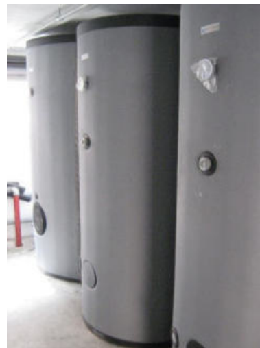
Accumulo solare e sanitario e circuiti solare
