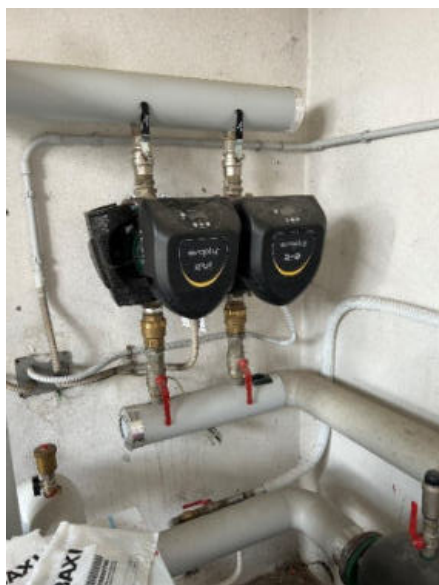
Collettore circuiti termici riscaldamento
