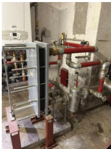
Generatore termico e scambiatore
