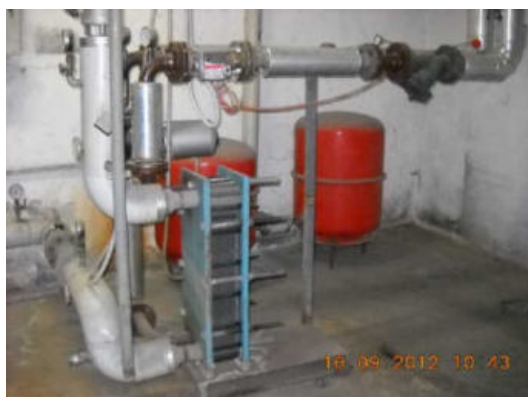
Scambiatore di calore
