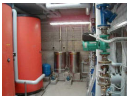
Circuito solare ed accumuli sanitario solare
