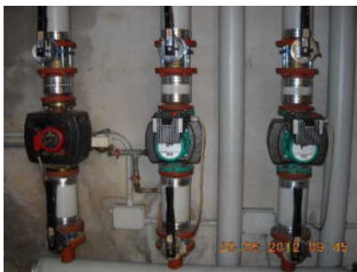
Collettore circuiti termici
