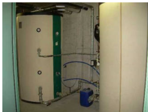
Accumulo solare e sanitario
