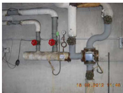
Collettore circuiti termici
