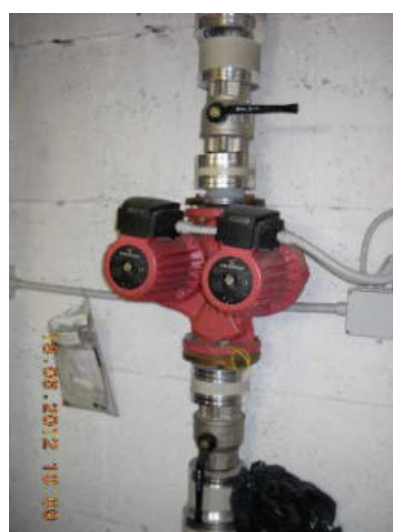
Collettore circuiti termici
