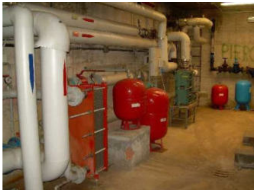
Scambiatori riscaldamento e sanitario da teleriscaldamento
