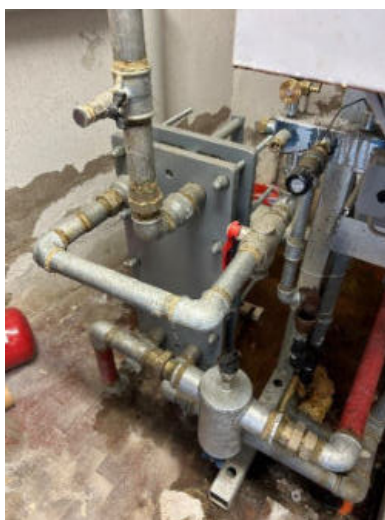
Generatore termico e scambiatore primario
