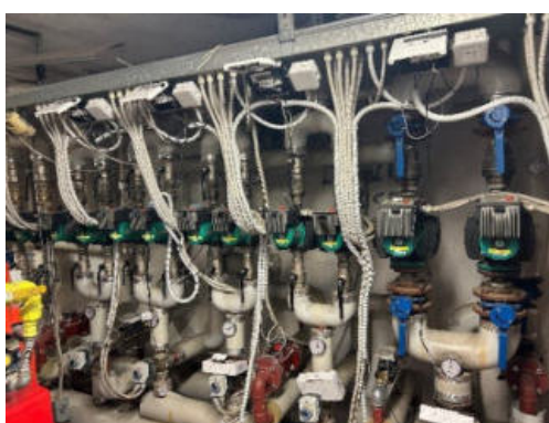
Collettore circuiti termici
