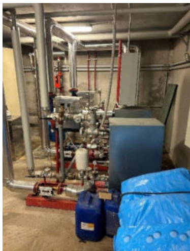
Generatori termici riscaldamento e sanitario da teleriscaldamento
