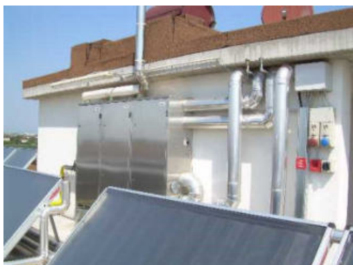
Generatori termici riscaldamento e sanitario
