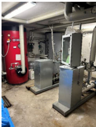
Generatori termici riscaldamento e sanitario da teleriscaldamento ed accumuli sanitario e solare
