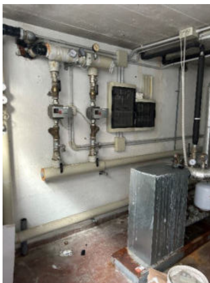
Collettore circuiti termici riscaldamento
