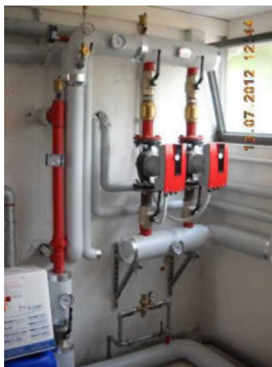
Collettore circuiti termici riscaldamento
