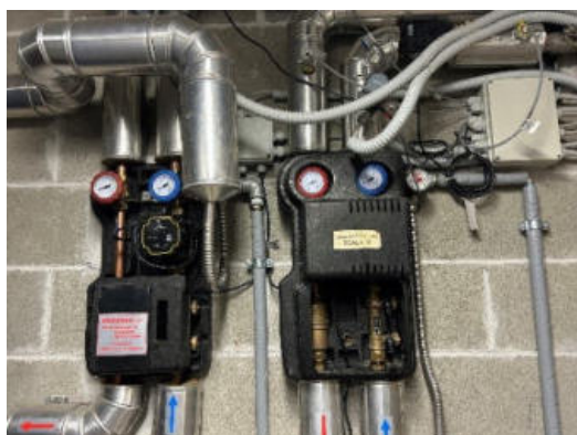
Pompe impianto solare
