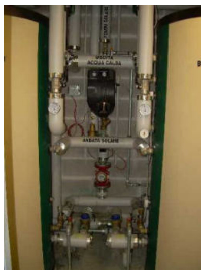
pompa solare e circuiti solare
