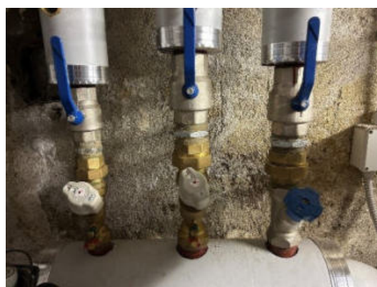
Collettore circuiti termici
