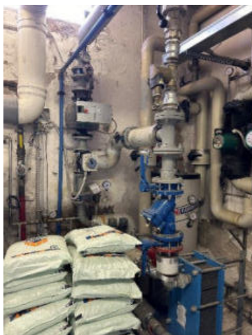
Collettore circuiti termici
