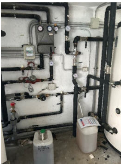
Pompa solare e valvola a 3 vie sanitaria
