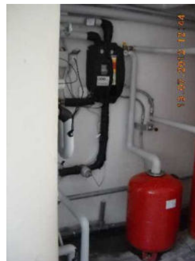
Pompa solare
