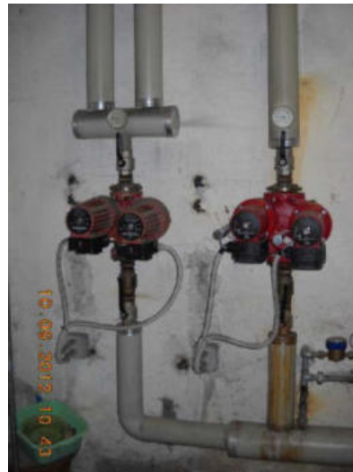
Collettore circuiti termici
