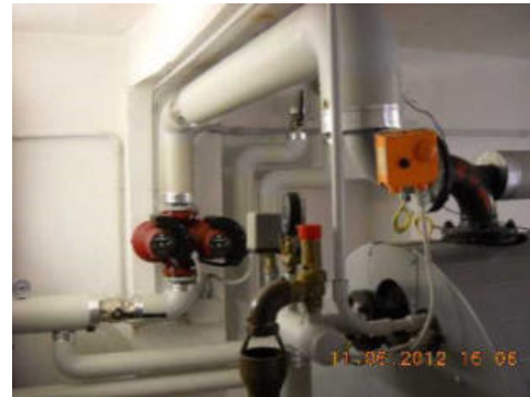
Apparecchiature di centrale (distribuzione circuito primario e sicurezze)
