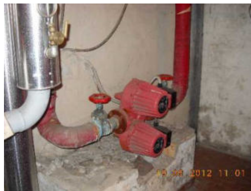
Collettore circuiti termici
