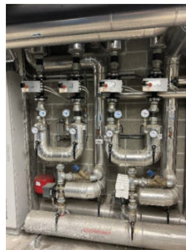
Collettore circuiti termici riscaldamento
