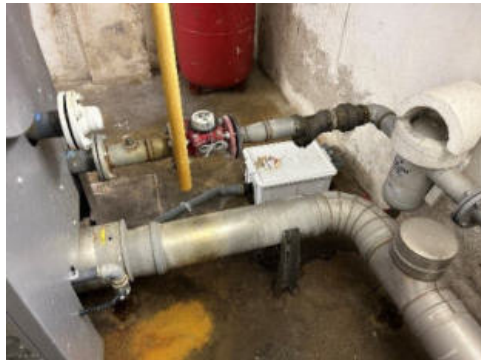
Apparecchiature di centrale (distribuzione circuito primario e sicurezze)
