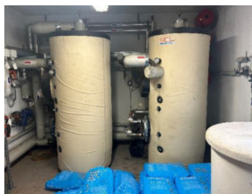
Accumulo sanitario e solare
