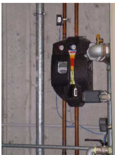
Pompa impianto solare
