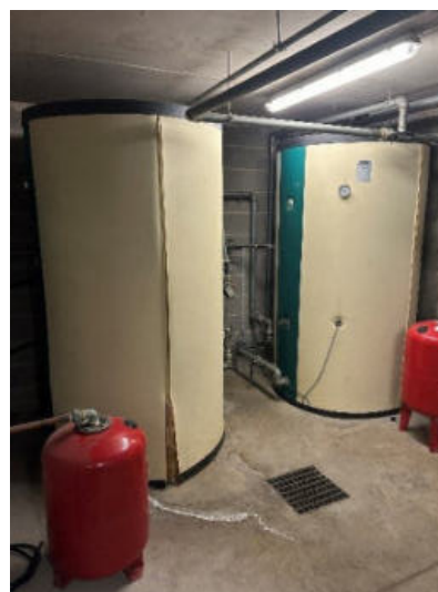
Accumulo solare e sanitario
