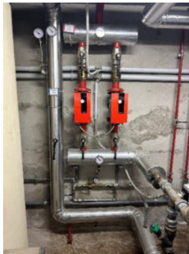
Collettore circuiti termici riscaldamento
