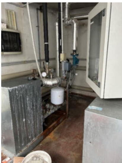
Generatori termici riscaldamento e sanitario da teleriscaldamento
