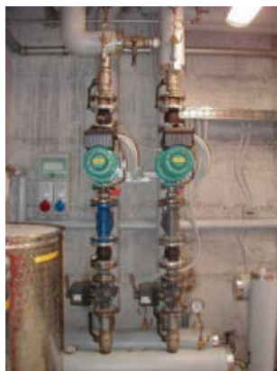
Pompe primario solare
