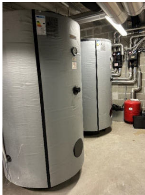
Accumulo sanitario e solare
