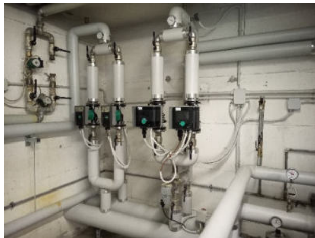
Collettore circuiti termici
