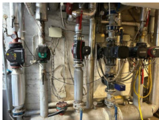
Collettore circuiti termici
