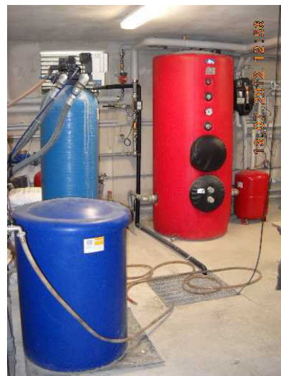
Accumulo solare e sanitario
