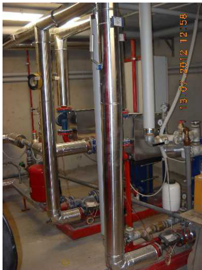
Generatori termici riscaldamento e sanitario da teleriscaldamento
