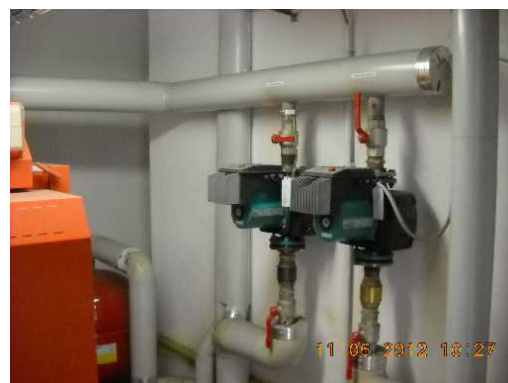
Collettore circuiti termici
