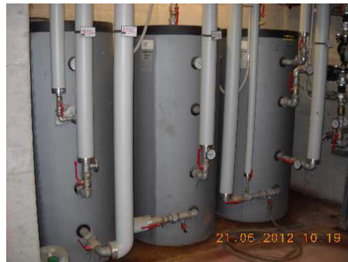
Accumulo sanitario e scambio solare
