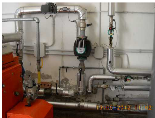
Collettore circuiti termici
