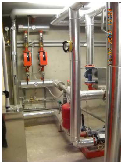
Collettore circuiti termici riscaldamento
