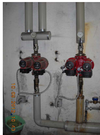
Collettore circuiti termici
