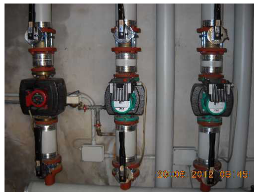
Collettore circuiti termici
