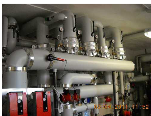
Collettori circuiti termici riscaldamento e sanitario
