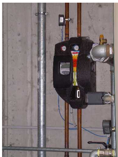
Pompa impianto solare
