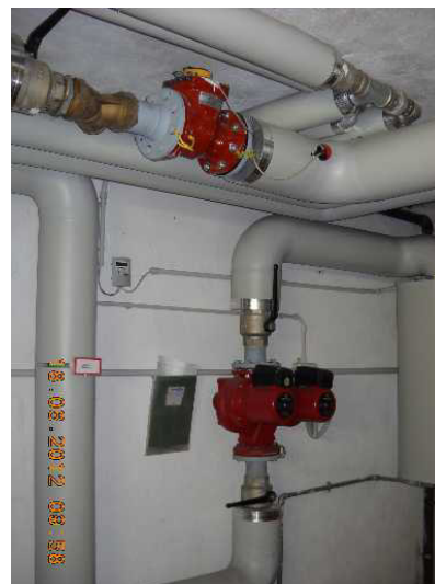
Collettore circuiti termici
