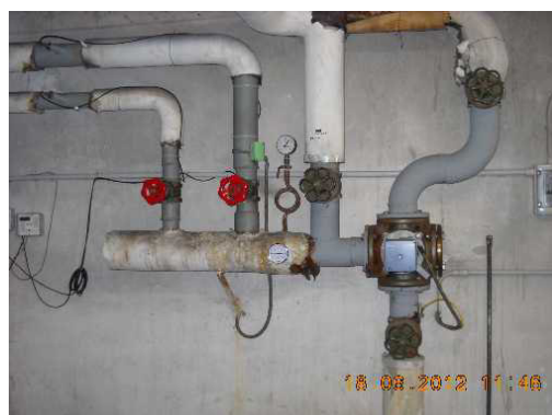
Collettore circuiti termici
