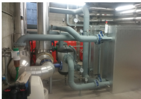
Collettore circuiti termici
