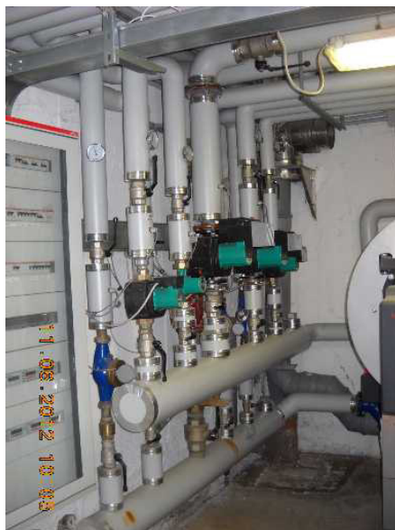
Collettore circuiti termici
