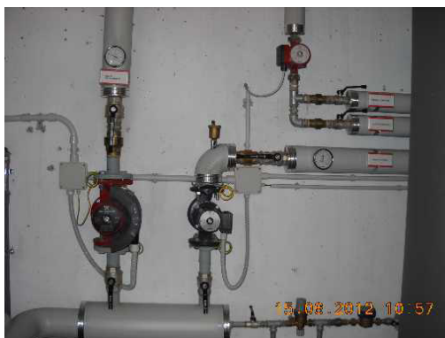
Collettore circuiti termici
