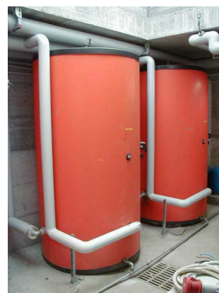
accumuli sanitario solare
