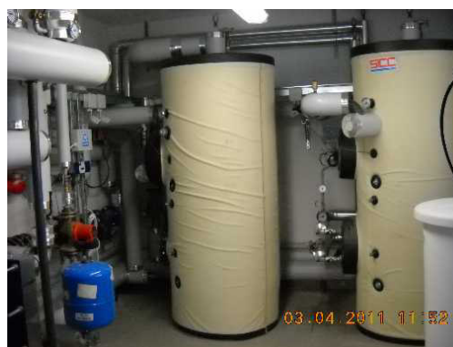
Accumulo solare e sanitario e circuito solare
