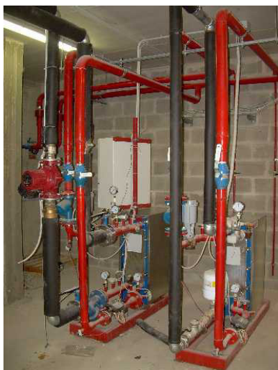
Generatori termici riscaldamento e sanitario da teleriscaldamento
