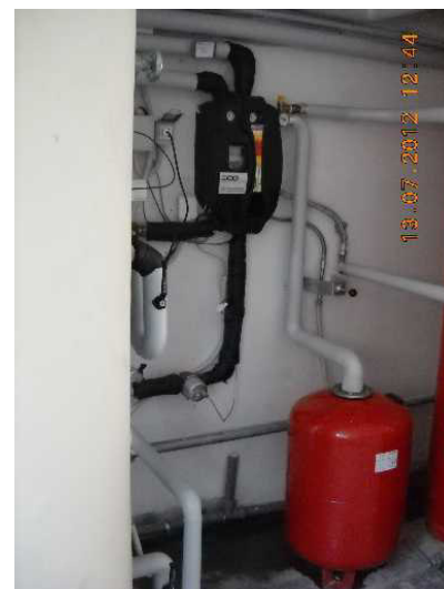
Pompa solare
