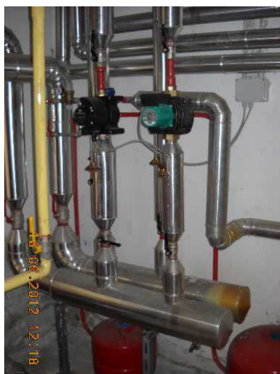
Collettore circuiti termici
