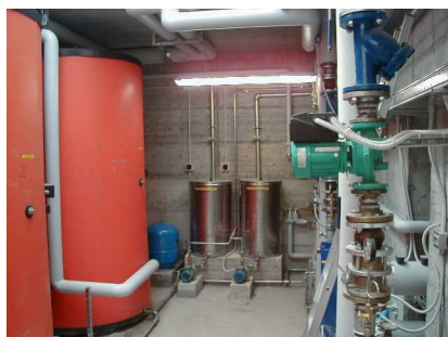
Circuito solare ed accumuli sanitario solare
