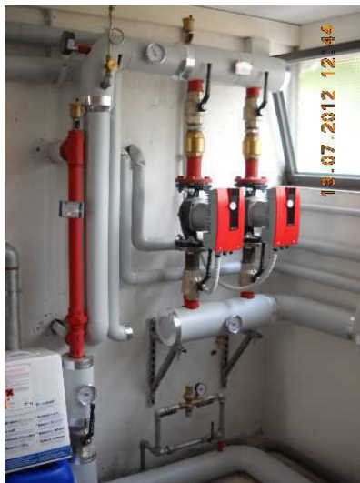
Collettore circuiti termici riscaldamento
