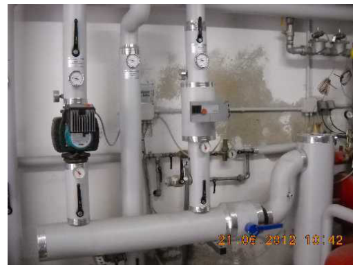
Collettore circuiti termici
