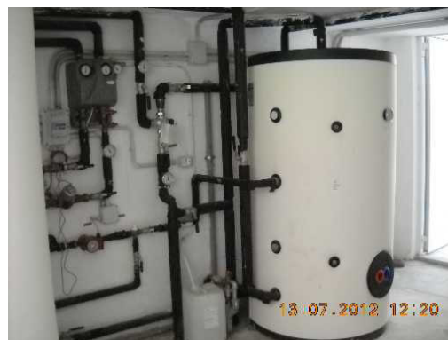
Accumulo sanitario e pompa solare
