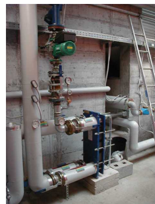
Pompa secondario solare e scambiatore solare
