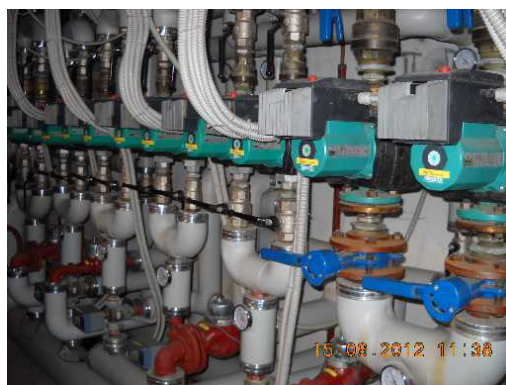
Collettore circuiti termici
