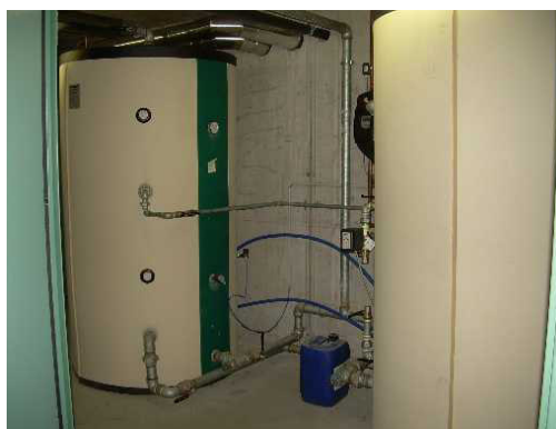
Accumulo solare e sanitario
