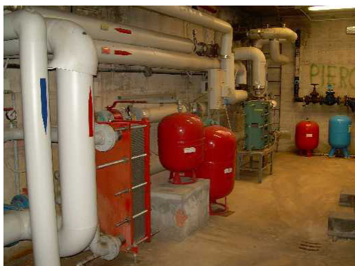
Scambiatori riscaldamento e sanitario da teleriscaldamento
