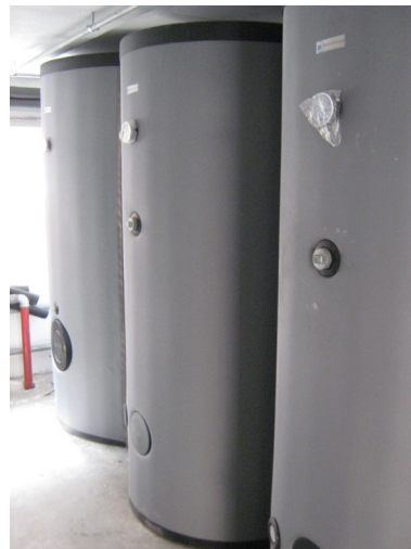
Accumulo solare e sanitario e circuito solare
