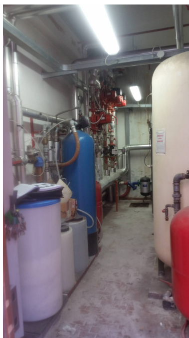
Collettore circuiti termici
