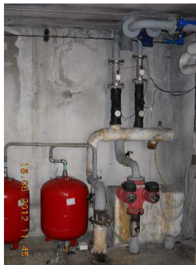
Collettore circuiti termici
