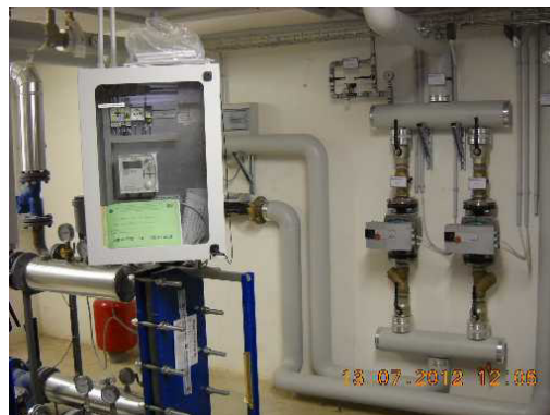
Collettore circuiti termici riscaldamento
