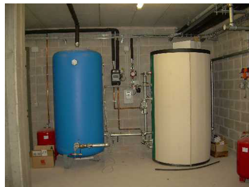
Accumulo solare e sanitario e circuiti solare
