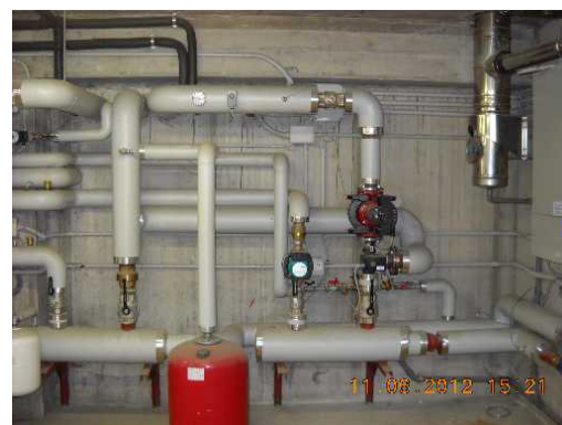
Collettore circuiti termici
