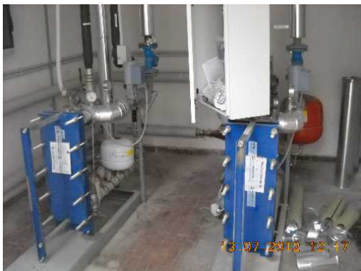
Generatori termici riscaldamento e sanitario da teleriscaldamento
