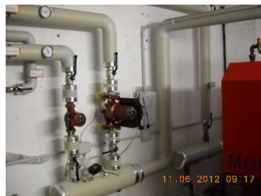
Collettore circuiti termici
