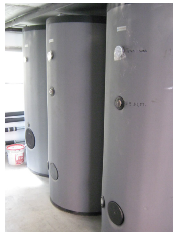
Accumulo solare e sanitario e circuito solare
