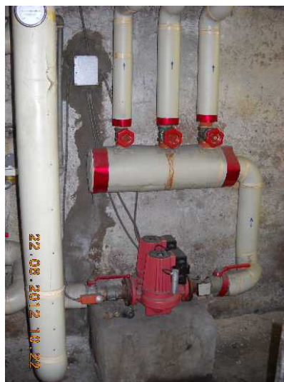
Collettore circuiti termici
