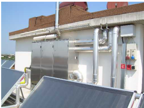
Generatori termici riscaldamento e sanitario
