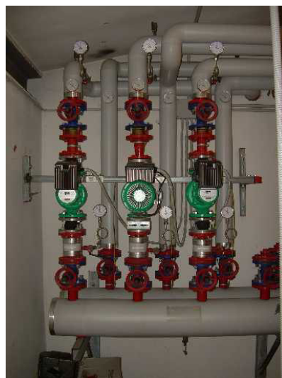
Collettore circuiti termici
