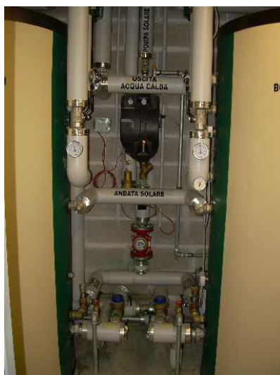
pompa solare e circuito solare
