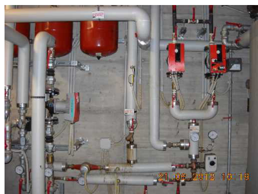
Collettore circuiti termici solare
