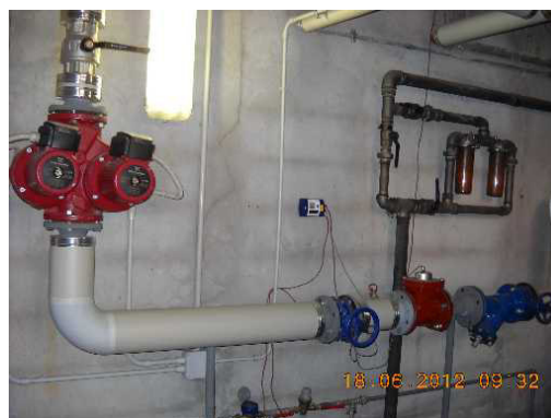
Collettore circuiti termici
