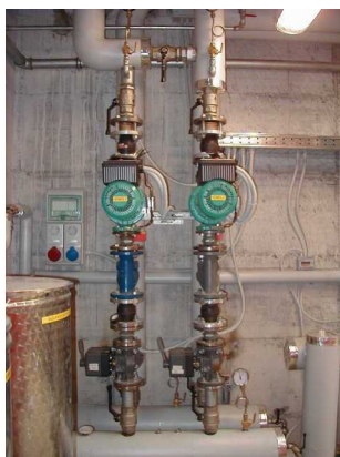
Pompe primario solare
