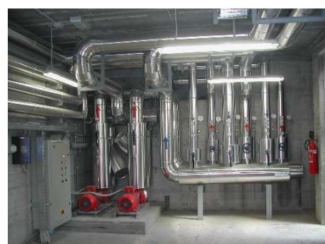
Collettore circuiti termici
