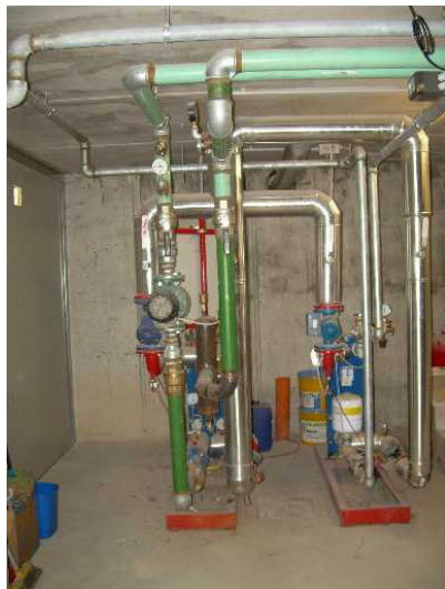
Generatori termici riscaldamento e sanitario da teleriscaldamento
