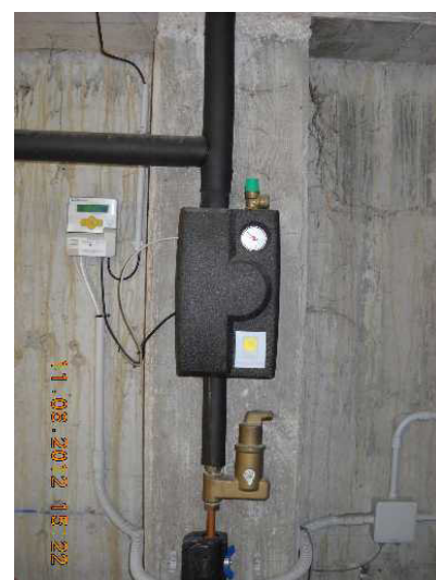
Centrale gestione solare
