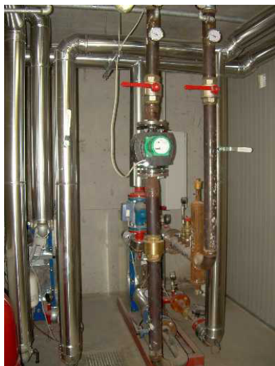
Generatori termici riscaldamento e sanitario da teleriscaldamento
