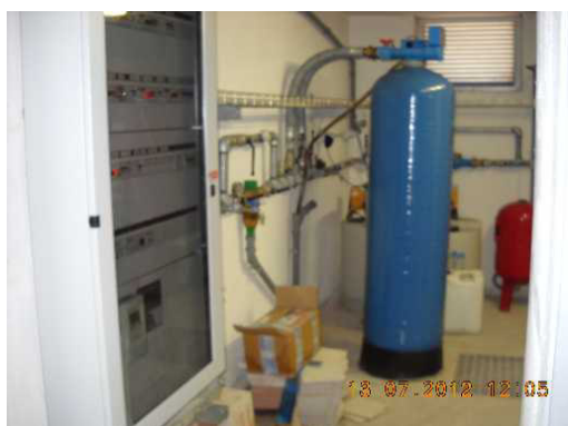
Quadro elettrico e gestione e gruppo addolcimento
