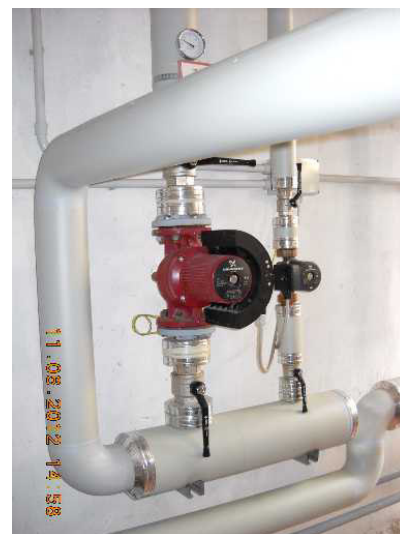
Collettore circuiti termici
