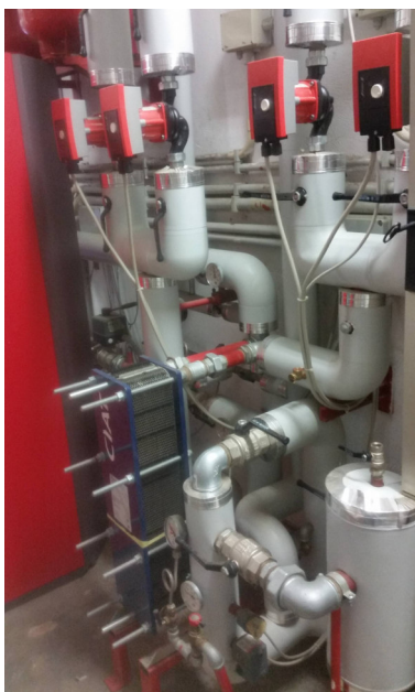
Collettore circuiti termici
