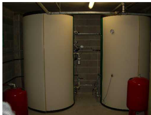
Accumulo solare e sanitario
