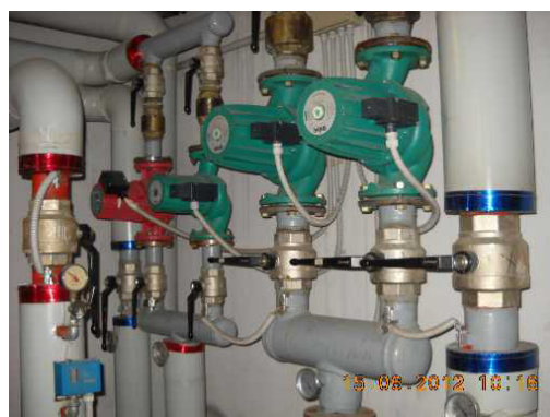
Collettore circuiti termici
