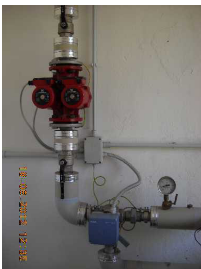
Collettore circuiti termici
