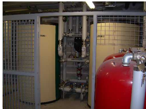
Accumulo solare e sanitario e circuito solare
