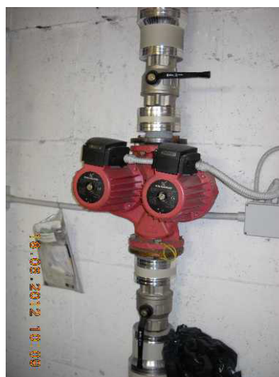
Collettore circuiti termici
