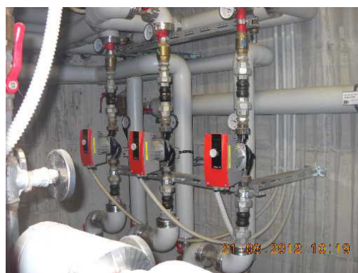
Collettore circuiti termici riscaldamento
