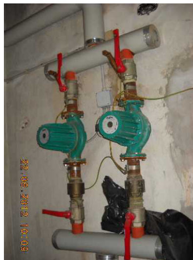
Collettore circuiti termici
