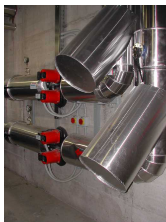
Pompe lato primario caldaie
